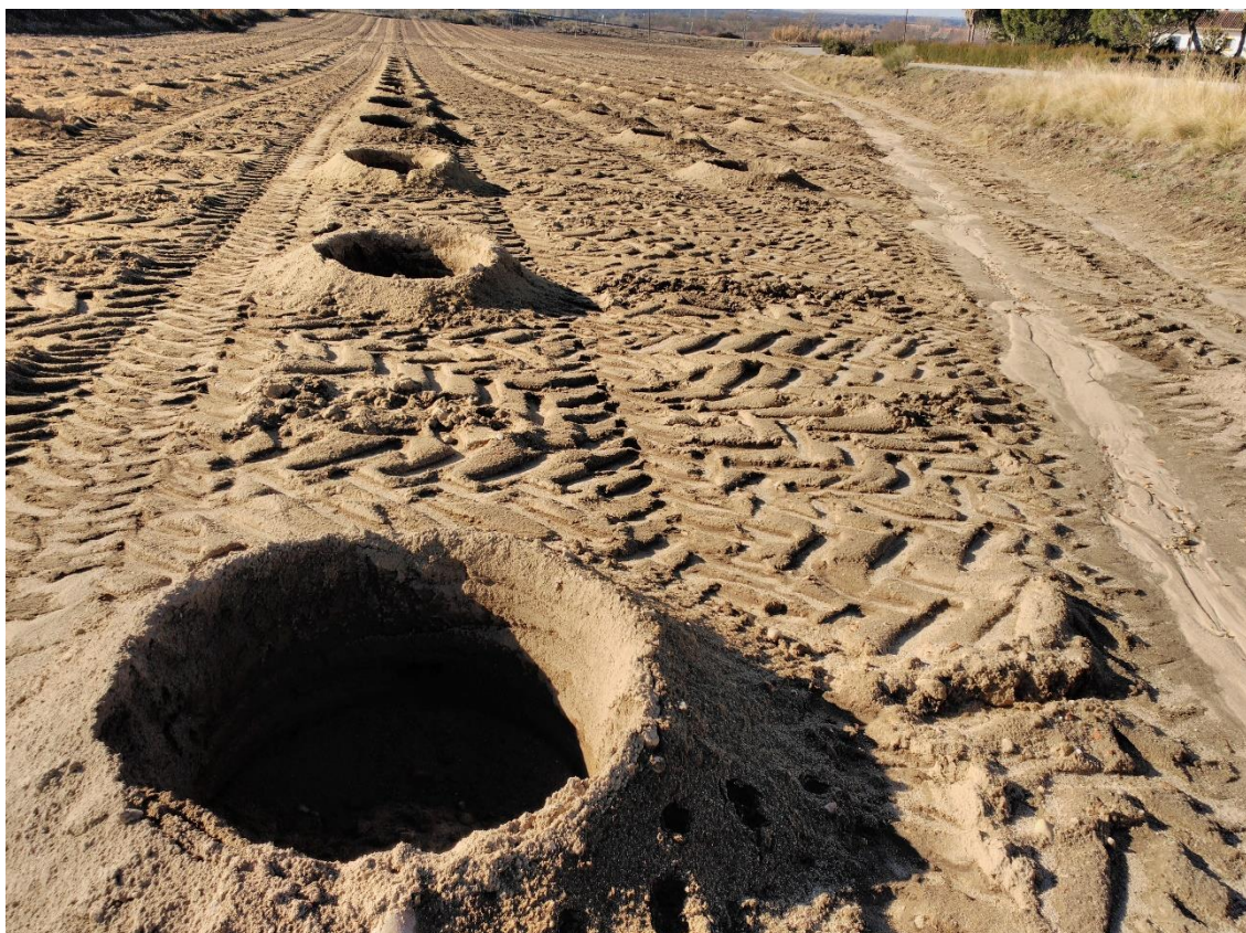
Foto nº 2 Ejecución de hoyos para implantación.
