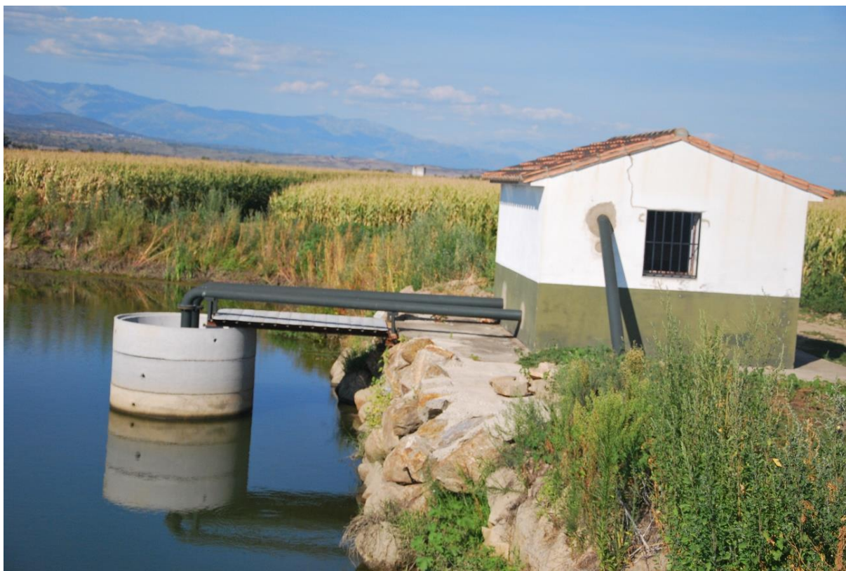
Foto nº . Imagen de la actual caseta de bombeo, que se mantendrá en las mismas condiciones actuales.
